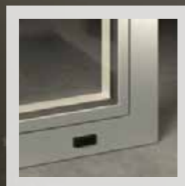
Nodo laterale con cerniera a scomparsa
