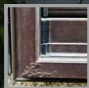
Senza trattamento degli angoli anti corrosione
